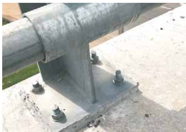
Монтаж дорожных ограждений
