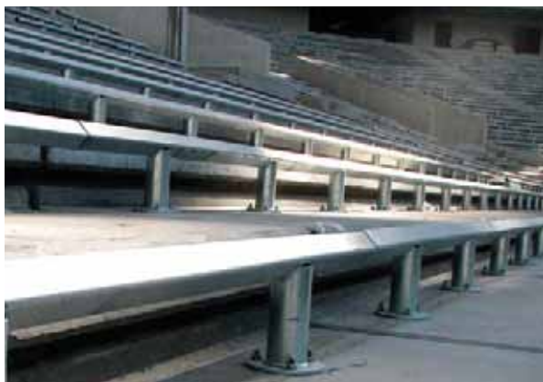
Монтаж кресел стадионов
